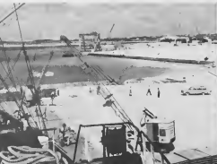
E BAPOR Isis tabata e promer bapor di carga pa drenta Haaf di Barcadera. E portretnan aki riba ta muestra e waf na unda el a marrá cu e instalacionnan di plantanan quimico y di fertilizantes, mas atras. E extensividad di e haaf ta mostrá, banda drecha, cu e barco Isis marrá, banda robes. E bapor di carga a trece plancha di concreto.
